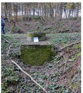
Il s'agit d'un puits en béton de 2,20 m de profondeur repris en 1971, constitué de buses en bon état qui émergent de 30 cm côté amont. Il est fermé par un capot étanche en fonte, dépourvu d'aération.
