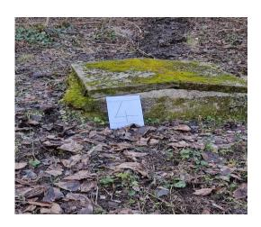
Il s'agit d'un ouvrage maçonné sommaire constitué d'un regard maçonné de 90 cm de côté et dont la profondeur n'est pas déterminée.
