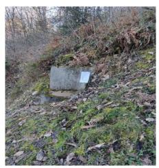
Ce captage, supposé dater de 1971, est constitué d'un édifice enterré et maçonné débouchant au niveau du sol naturel.
