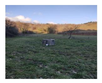
L'ouvrage datant de 1900 a été repris en 1980.Il est constitué de buses en béton, qui émergent de 1,30 m par rapport au terrain naturel. Il est fermé par un capot étanche en béton, dont le pourtour se désagrège, et par une trappe d'accès.
