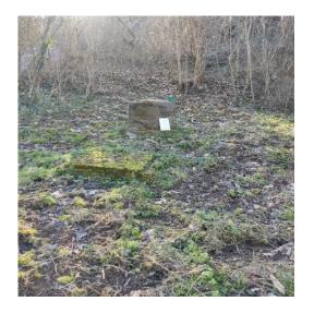
Le captage de la source « Ancienne Grande » date de 1937. Il est constitué d'une buse en béton, émergeant de 65 cm du sol, fermée par un capot étanche en fonte et d'un regard en béton.
