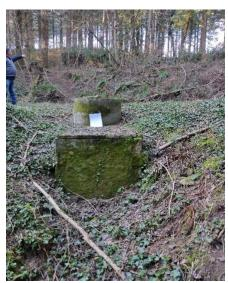
L'ouvrage, dont la réalisation est concomitante au précédent, est un puits profond de 2,25 m, réalisé par empilement de buses en béton Ø 80 cm. Elles émergent de 15 cm environ côté amont et de 50 cm côté aval.
